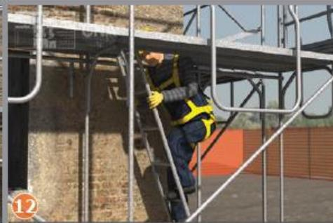
12 TERMINATO IL MONTAGGIO DEI PARAPETTI (ANCHE DEI PARAPETTI DI TESTATA) SI PUÒ SALIRE AL PIANO SUPERIORE PER IL MONTAGGIO DEI TELAI.
