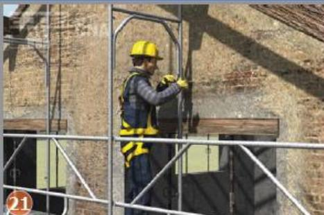
21 GLI ANCORAGGI AL MURO DEVONO ESSERE SMONTATI, QUANDO SI INTERVENE SUL PIANO DA SMONTARE. E' VIETATO SMONTARE GLI ANCORAGGI DEI PIANI SOTTOSTANTI AL PIANO DI CALPESTIO DURANTE LE FASI DI SMONTAGGIO.
