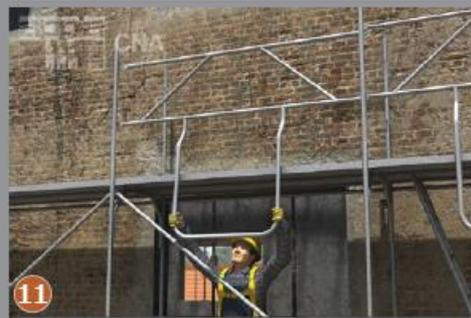
11 DAL PIANO INFERIORE, MONTARE I PARAPETTI DEL PIANO SUPERIORE (ANCHE SUL TELAIO DI TESTATA), SUCCESSIVAMENTE ESEGUIRE:
