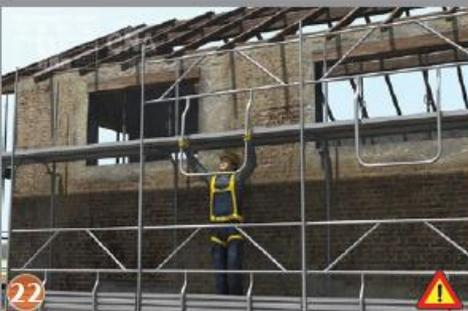
22 DAL PIANO INFERIORE, SMONTARE I PARAPETTI DEL PIANO SUPERIORE.
