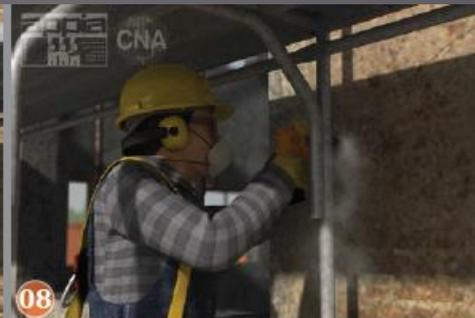
08 DOPO CHE IL PIANO DEL PONTEGGIO È STATO ASSESTATO ED È IN BOLLÀ, REALIZZARE GLI ANCORAGGI ALLA PARETE E/O ALLA STRUTTURA DEL MANUFATTO.
